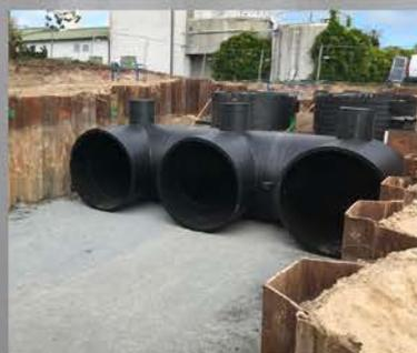
Ouvrage de régulation et de relevage des eaux usées de 200 m<sup>3</sup>.
