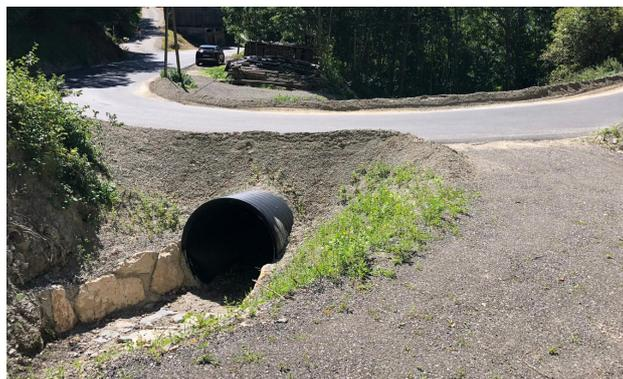
Installé sous la RD 89 à Montagny (73), l'ouvrage PEHD WEHOLITE est venu en remplacement du pont des Eparays.
