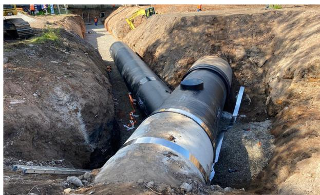
Le réseau unitaire de Stiring Wendel (57), conçu avec des matériaux traditionnels, avait besoin d'une rénovation et d'une amélioration pérenne. La solution variante PEHD WEHOLITE a été retenue pour plusieurs raisons, les plus importantes étant la résistance à l'H<sub>2</sub>S et son adaptabilité.
