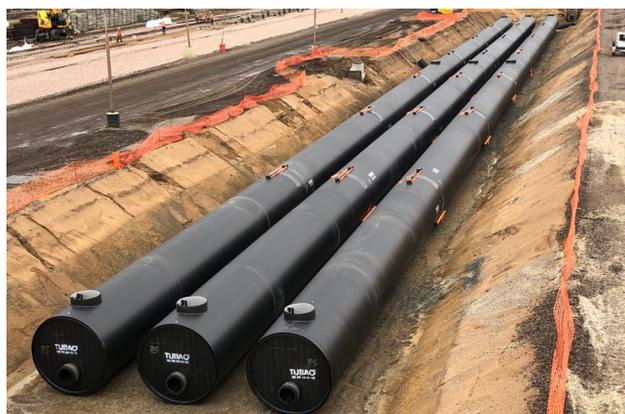
Dans le cadre du regroupement de toutes ses activités de maintenance du matériel ferroviaire sur le site de NANTES Blottereau, la SNCF a été amené à installer deux bassins de rétention des eaux pluviales composés de 25 buses en polyéthylène de grand diamètre assemblées par soudure.
