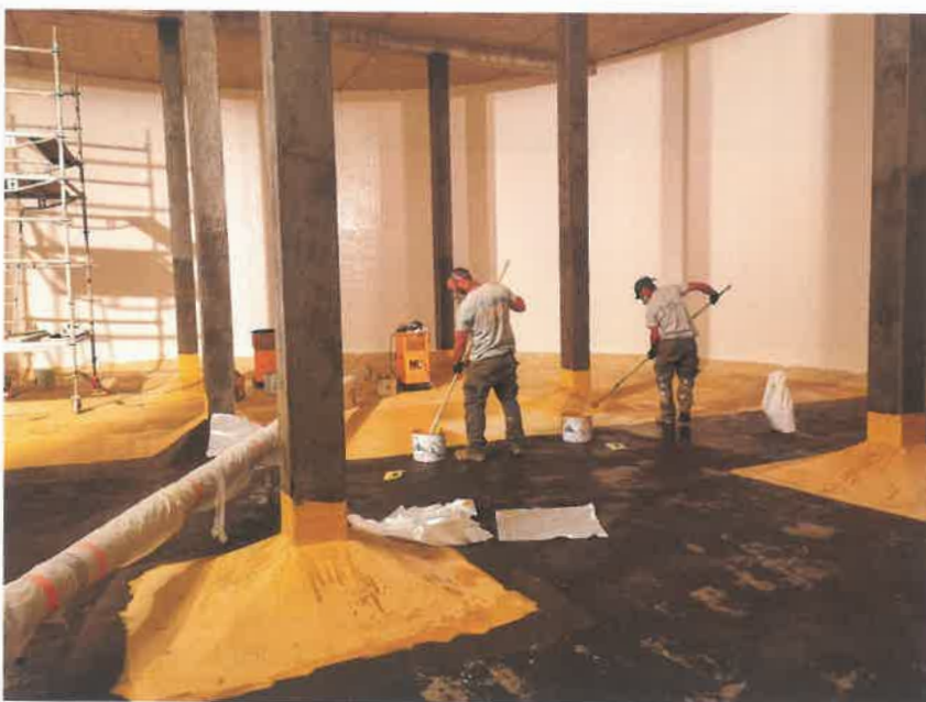
Le chimiste spécialisé Sob Solutions commercialise, sous la marque Protecso ® , un ensemble de produits à base d'époxy, munis d'une ACS, pour la réhabilitation des réservoirs d'eau potable.
