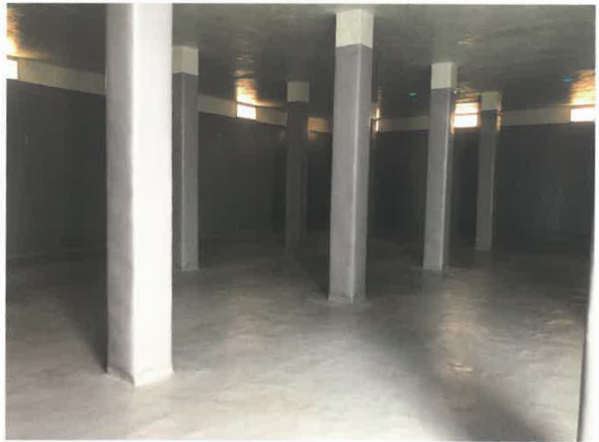
Renolit propose des membranes PVC dotées d'une ACS pour la réhabilitation des réservoirs d'eau potable, comme ici en Espagne.
