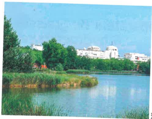
La mise en place d'ouvrages régulateurs d'eaux pluviales à ciel ouvert confère une cohérence à l'ensemble du territoire de la ville. L'eau devient un élément structurant et fédérateur du projet urbain.
