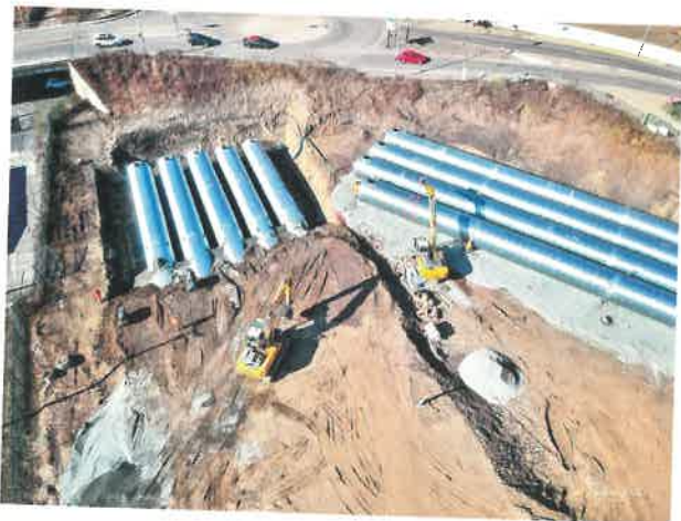
Pour collecter les eaux pluviales sur la zone commerciale du Steel à Saint Etienne, Tubosider France a fourni deux bassins de rétentions de 2.240 m 3 stockés dans 334 ml de tuyaux en diamètre 2.900 mm et 1.434 m 3 stockés dans 214 ml de tuyaux de diamètre 2.900 mm.
