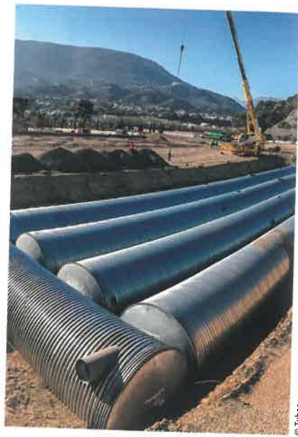
Solution de stockage en acier gros volume, en diamètre 3000, mis en place par Tubao à Colomars (06).
